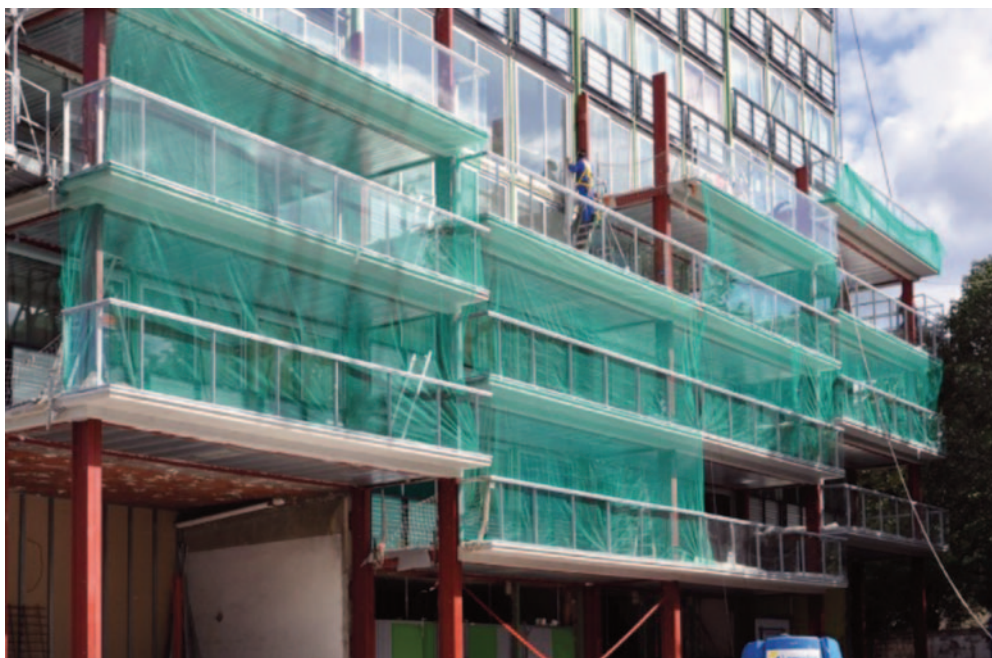
Travaux de la tour du Bois-le-Prêtre (Paris, XVIIe arr.) : installation des jardins d'hiver.
